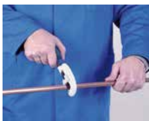
1. Corte de tubo 1. Cortar o tubo
