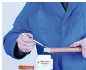
4. Aplicación del decapante 4. Aplicação do decapante
