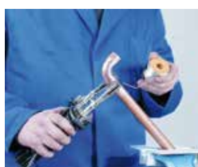
5. Aplicación de la soldadura 5. Aplicação da soldadura
