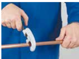
1. Corte de tubo 1. Cortar o tubo
