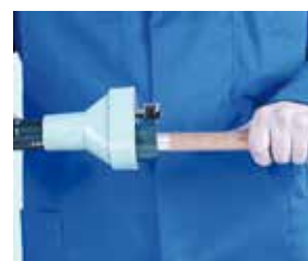
3. Limpieza exterior del tubo 3. Limpeza exterior do tubo
