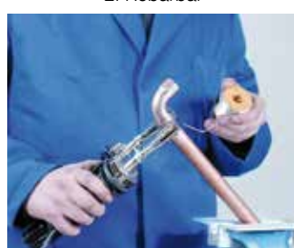
5. Aplicación de la soldadura 5. Aplicação da soldadura
