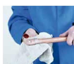
6. Limpieza final 6. Limpeza final
