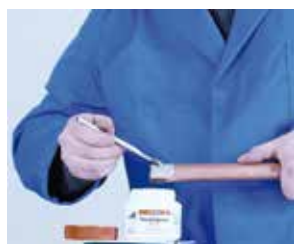
4. Aplicación del decapante 4. Aplicação do decapante
