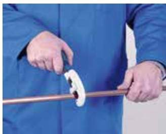
1. Corte de tubo 1. Cortar o tubo
