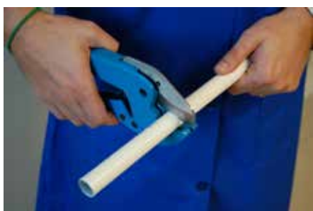
1. Cortar el tubo en ángulo recto 1. Cortar o tubo em ângulo recto
