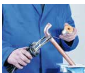
5. Aplicación de la soldadura 5. Aplicação da soldadura
