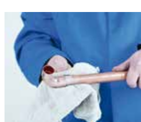
6. Limpieza final 6. Limpeza final
