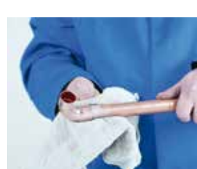
6. Limpieza final 6. Limpeza final
