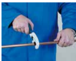
1. Corte de tubo 1. Cortar o tubo
