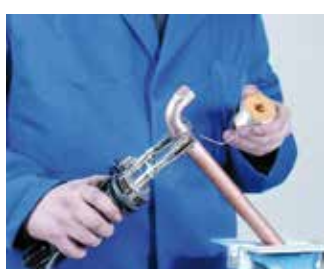
5. Aplicación de la soldadura fuerte 5. Aplicação da soldadura forte
