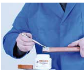
4. Aplicación del decapante 4. Aplicação do decapante
