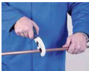
1. Corte de tubo 1. Cortar o tubo
